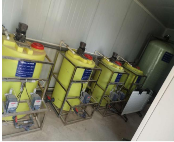
药研院 09 地块现状地下一体化污水处理设备及加药间 图9药研院09地块现状地下一体化污水处理设施及污水总排口情况
